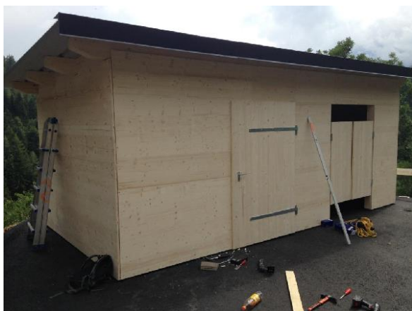
(local de voirie à Morcles)
