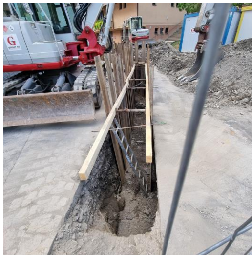
Mise en séparatif au Collège
